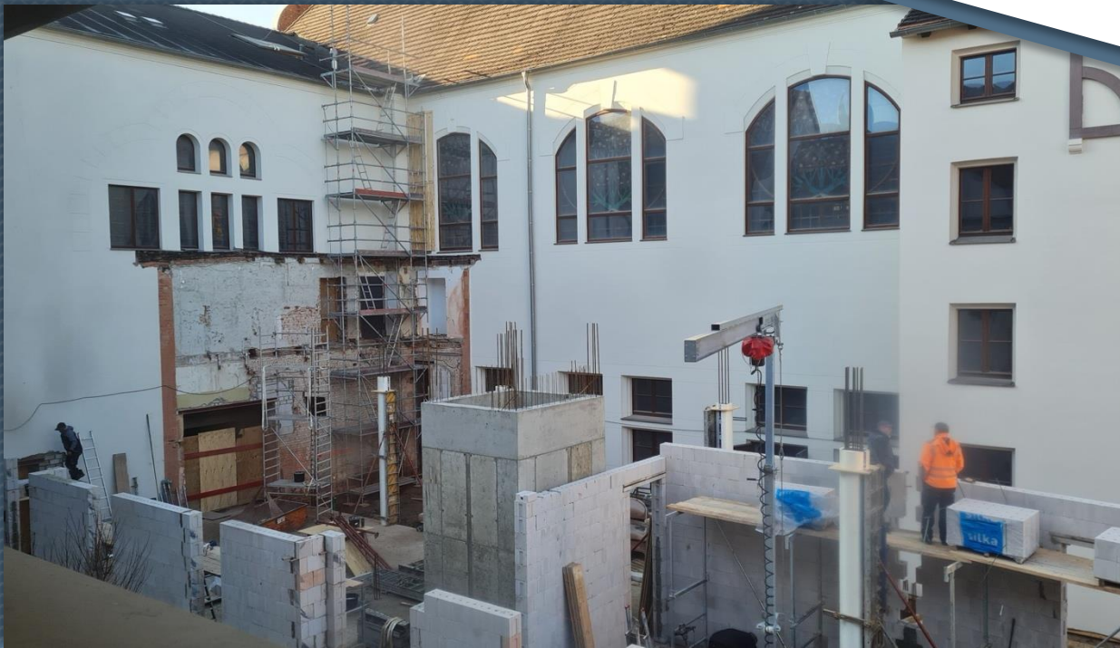
BEREICH: Innenhof Rohbauarbeiten EG / Decke über EG mit Aufzugsschacht
