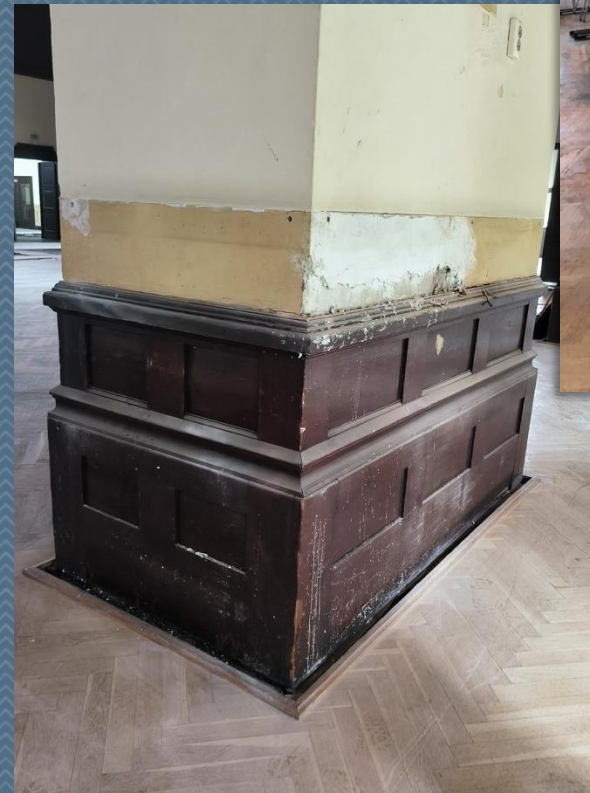
BEREICH: Großer Saal Stütze mit Paneelverkleidung / Nach Abbruch Originalzustand
