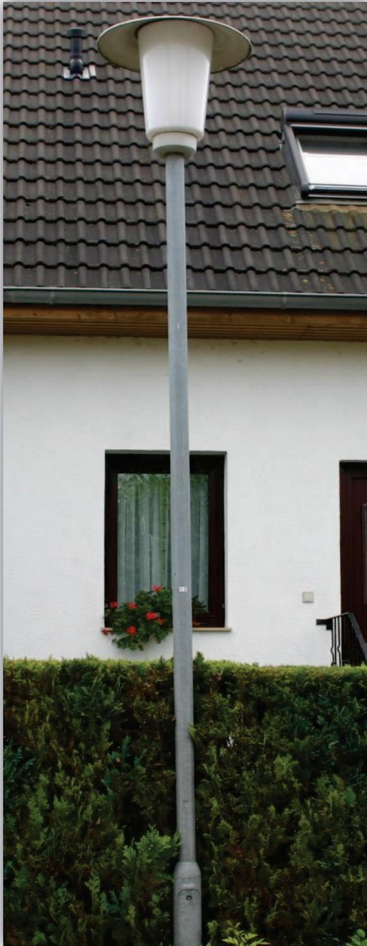
**Abb. 15: Pilzleuchte NA-Variante mit Mast**
