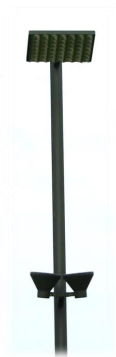
Abb. 59: Mast, Reflektor und Leuchten
