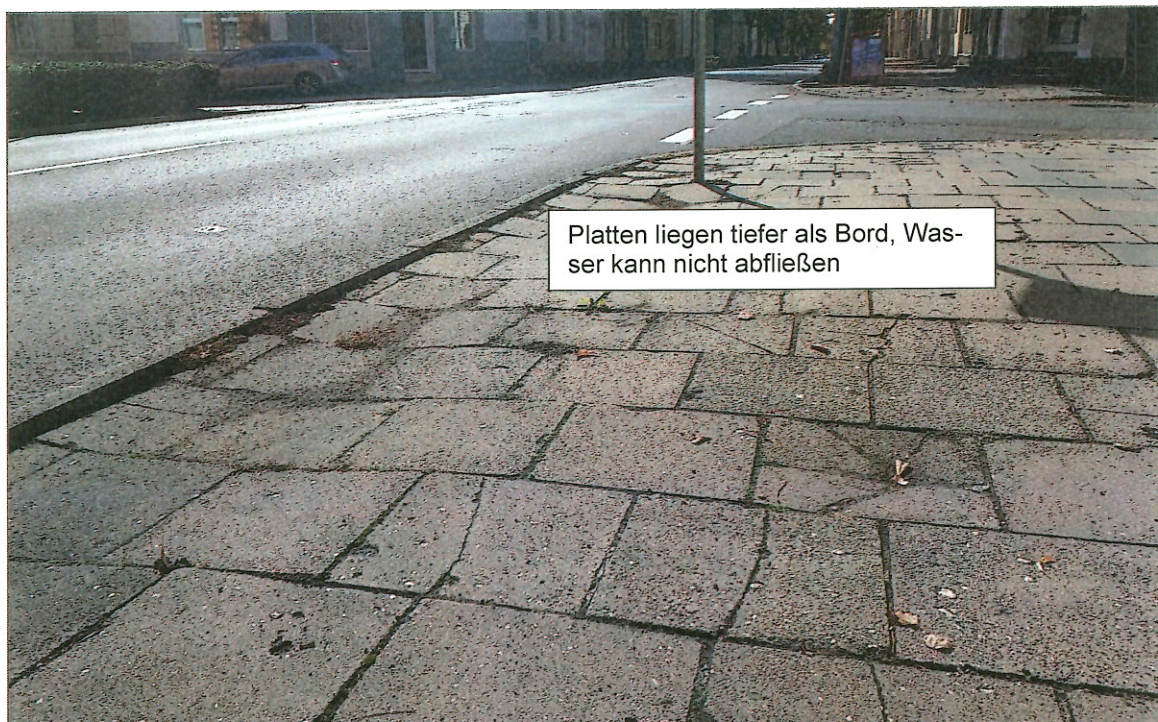
Gehweg im Bereich zwischen Schäferstraße und Stiftstraße
