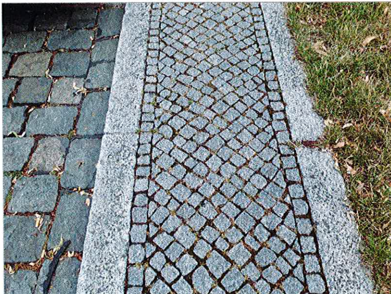
Bild 4: Beispiel der Verlegung von Mosaikpflaster in schmalen Randbereichen (diagonal, Anfang mit „Dreieckstein“)
