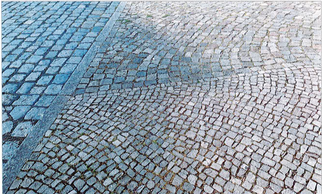
Bild 1: Beispiel Variante N-1 Käthe-Kollwitz-Straße – Bernburger Mosaik, Kleinpflaster in Zufahrt, Granitbord neu
