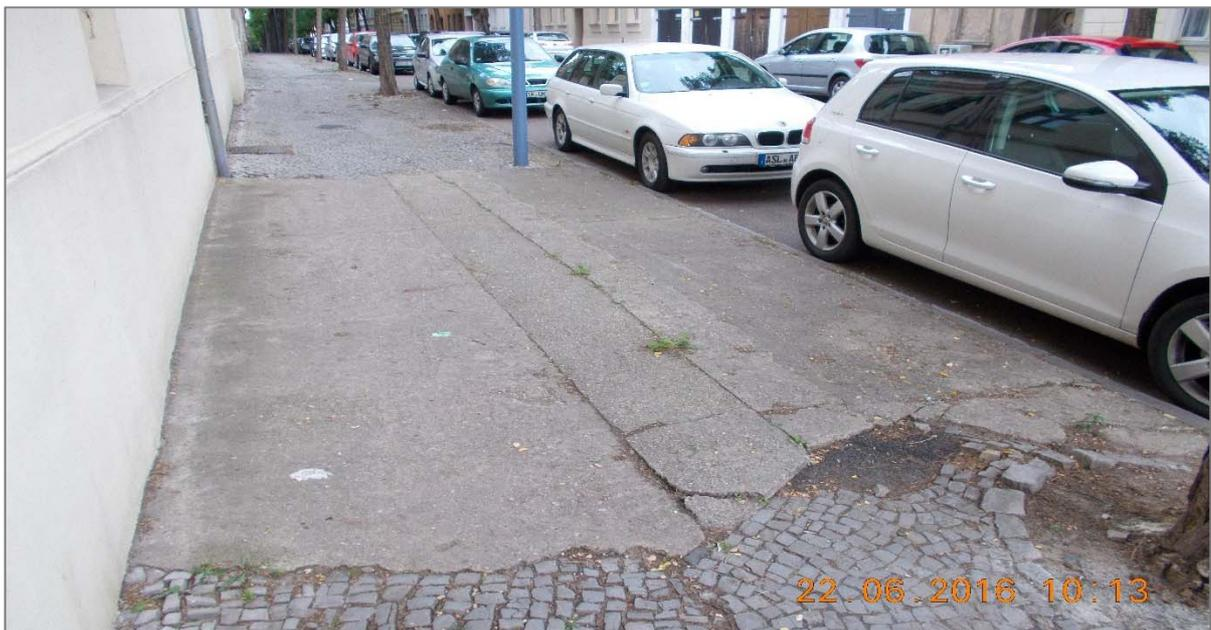
Hauptsächlich wurden durch die Baumwurzeln der Robinien Pflasteraufbrüche an der Oberfläche erzeugt. Diese wurden mit Beton oder Kaltmischgut wieder verschlossen, so dass ein regelrechter Flickenteppich entstand. Die provisorisch geschlossenen Aufbrüche sind teils selbst wieder geschädigt.
