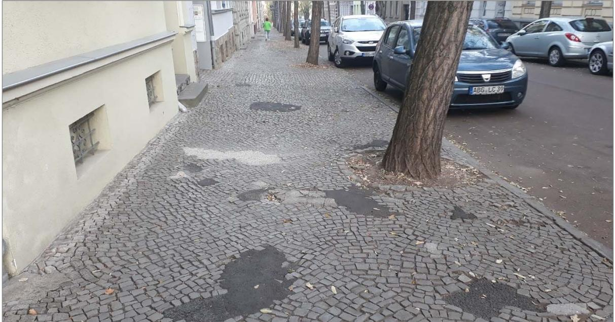
Insgesamt weisen die Gehwege eine unzulängliche, durch kleinteilige provisorische Reparaturen gekennzeichnete Oberfläche auf. Herausragende Wurzeln bilden zusätzliche Stolperfallen.
