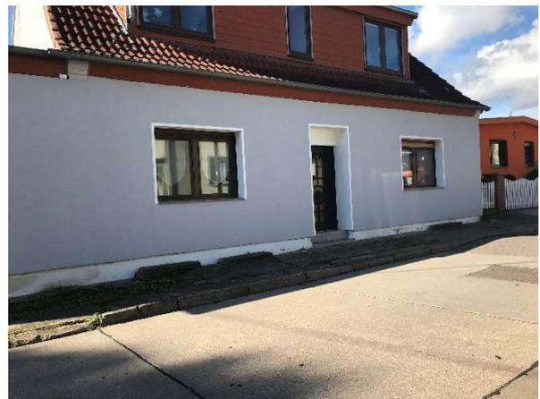
Der Gehweg vor dem **Wohngebäude Nr. 15A** ist größtenteils in Betonbauweise (Struktur Waschbeton) befestigt. Ein kleiner Streifen Betonrechteckpflaster quer zum Gehweg zeigt die mögliche Lage von nachträglich verlegten Versorgungsleitungen. Der Gehweg wird fahrbahnseitig von Betonborden eingefasst. Gebäudeseitig wird der Weg durch die Betonsockel der Grundstücksabzäunung eingefasst.
