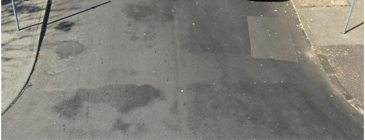
Bereiche mit Setzungen/ Tragfähigkeitsschäden
