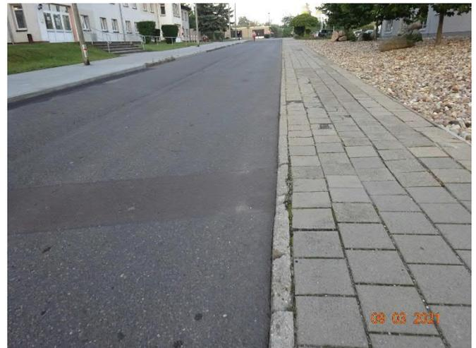
vorh. Gehweg mit Setzungen, gebrochenen Betonplatten und gebrochene Borde
