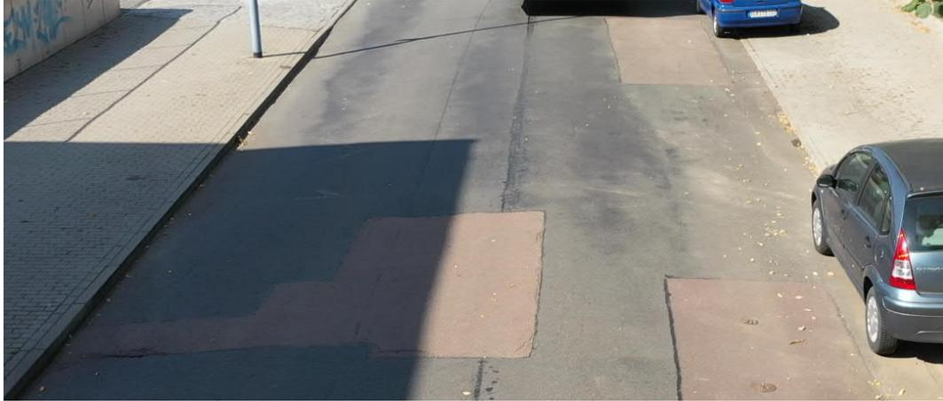
Oberfläche der Asphaltdeckschicht, unterschiedliche Asphaltqualitäten, Aufbrüche, Ausmagerung, Risse
