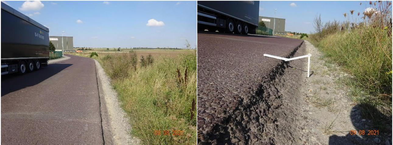
ausgefahrenes Bankett, freiliegende Asphaltflanken bis zur Tragschicht
