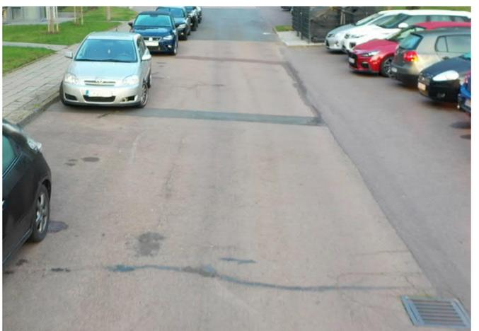
Längs-, Quer- und Netzzrisse, ausgemagerte Oberfläche
