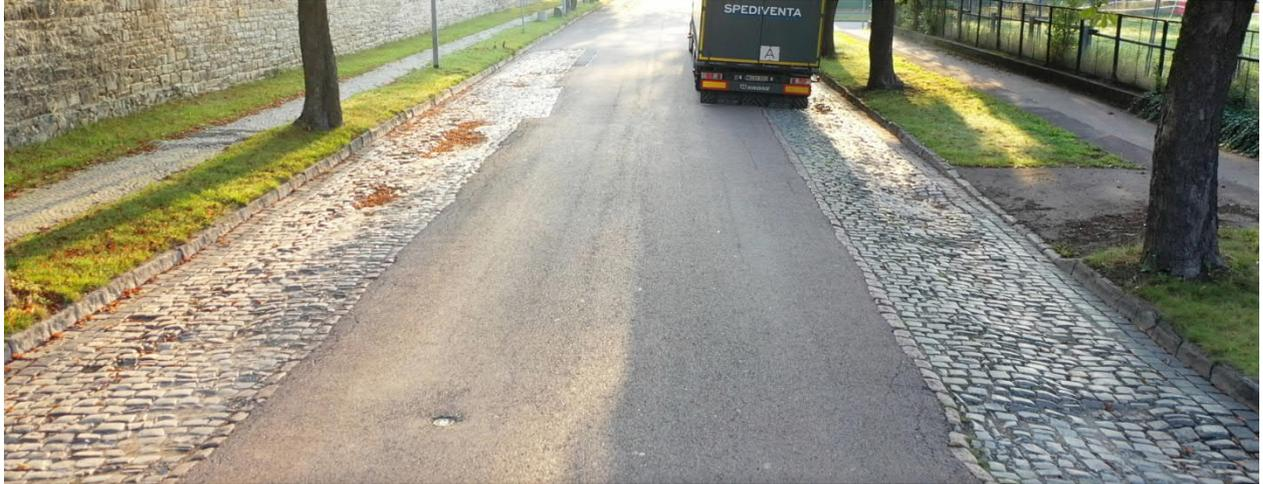
Setzungen, Fehlstellen, Kantenabbrüche, Risse im Asphalt
