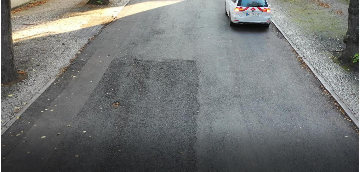
inhomogene Oberfläche, Risse, Fugen, Fehlstellen
