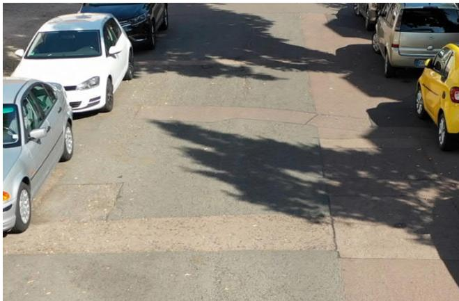
inhomogene Oberfläche, Risse, Fugen, Fehlstellen
