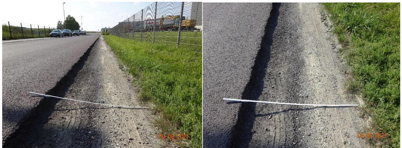
sichtbare LKW-Fahrspuren, beginnende Kanten- Abbrüche der Deckschicht. Höhendifferenz
