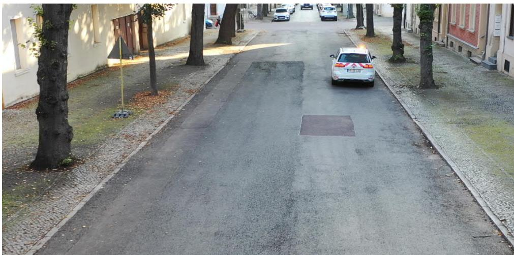
Oberfläche der Asphaltdeckschicht, unterschiedliche Asphaltqualitäten, Aufbrüche, Ausmagerung, Netzrisse
