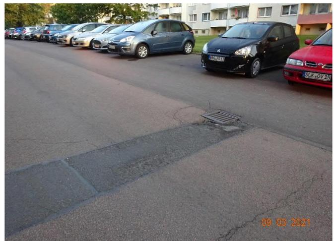
Straßenaufbrüche aus Leitungsverlegung bzw. sanierten Querfugen, Ausbrüche an Rändern
