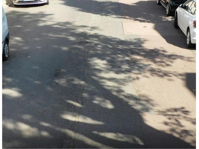
Oberfläche der Asphaltdeckschicht, unterschiedliche Asphaltqualitäten, Aufbrüche, Ausmagerung, Netzrisse
