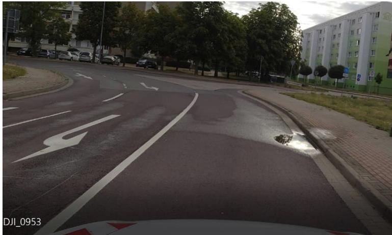
Vorh. Ausbau und Übergang zum Altbestand in der Einmündung, Reste der alten Betonfahrbahn, Aufweitungen aus Asphalt, gepflasterter Übergang in der Einmündung.
