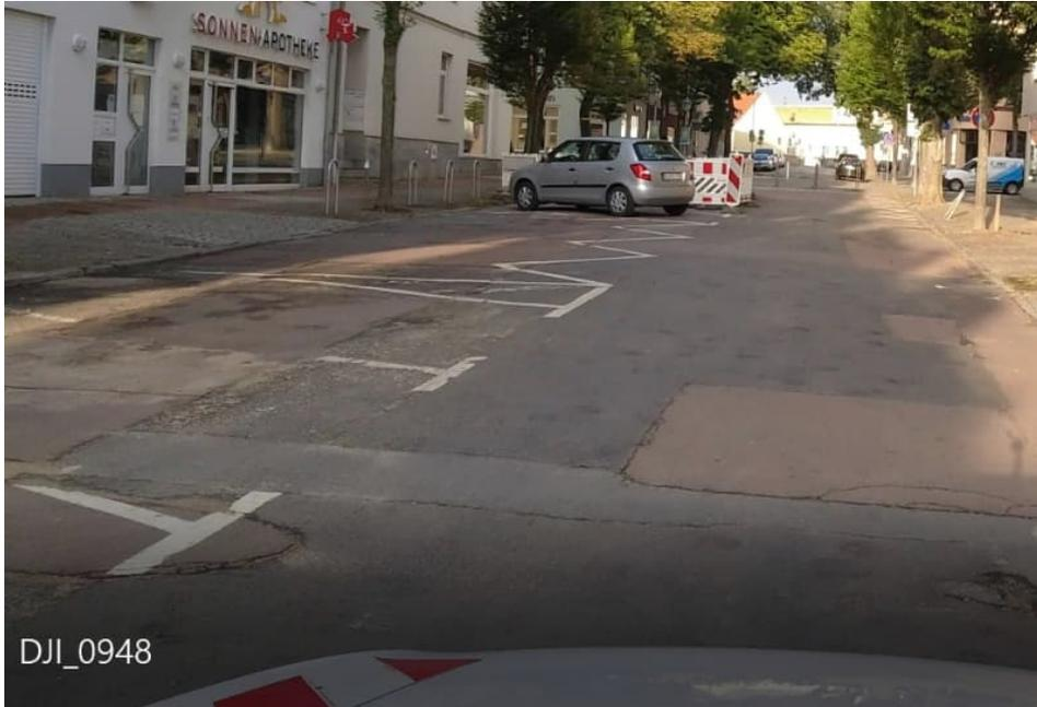
Oberfläche der Asphaltdeckschicht, unterschiedliche Asphaltqualitäten, Aufbrüche, Ausmagerung, Netzrisse
