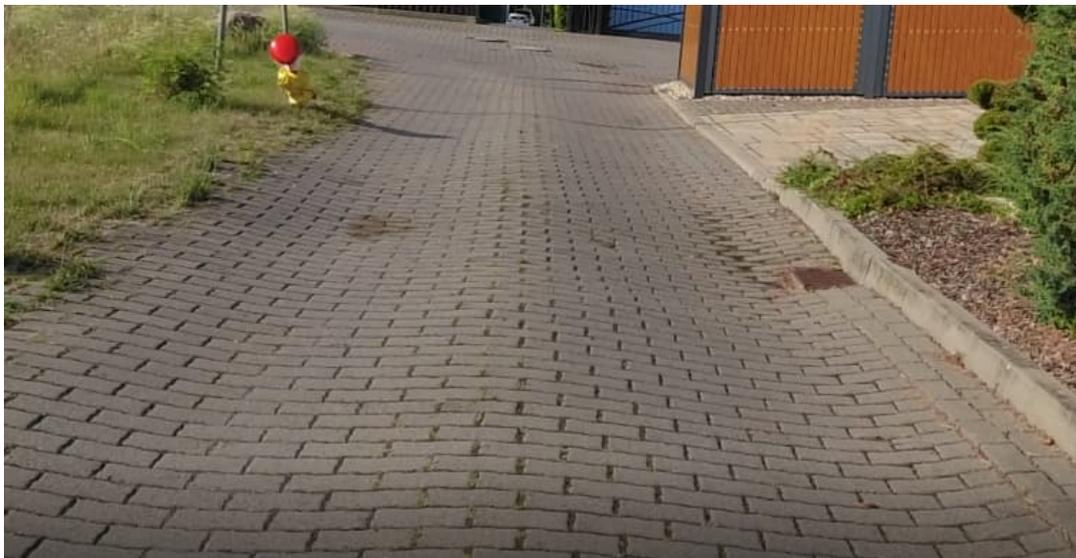
Setzungen in Fahrbahn und Bordanlage
