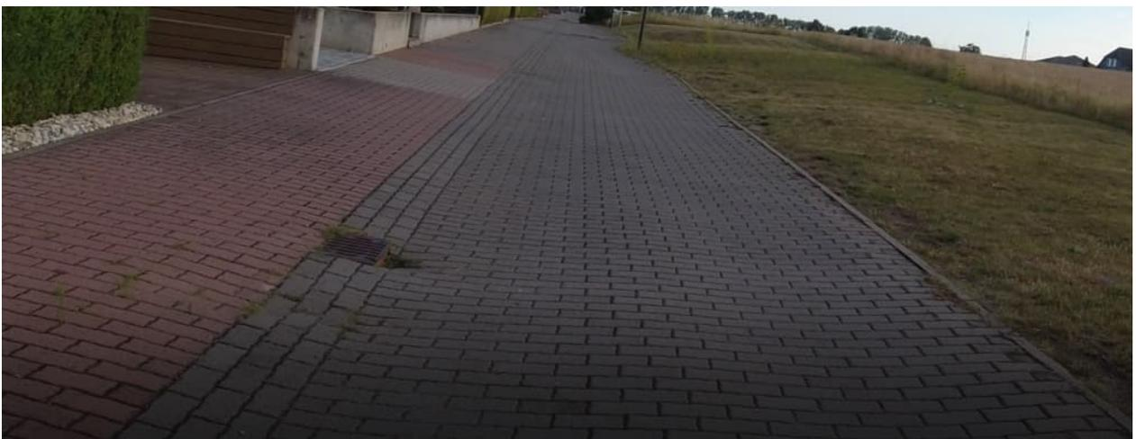
Verformte Oberfläche, Straßenablauf am seitlichen Hochpunkt ohne Funktion
