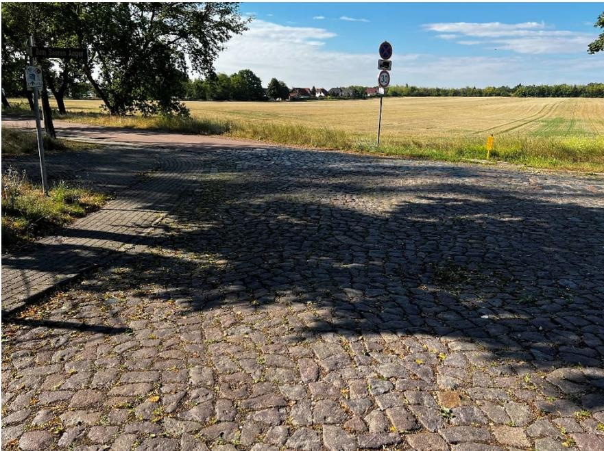
Unebenheiten und Verwerfungen im Pflaster, unterschiedliche Pflasterzonen nach Leitungsverlegung. Straße Am Sportlerheim mit Asphaltfahrbahn im Hintergrund
