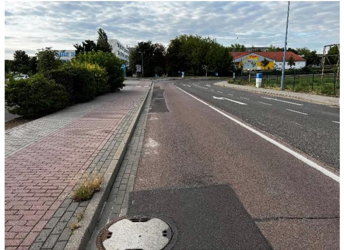
Längs- und Querfugen schlagen aus dem verschiedenartigen Unterbau durch
