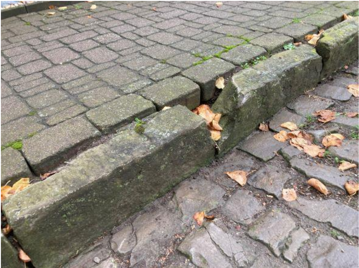
Abbildung 4: teilweise gebrochene Natursteinborde
