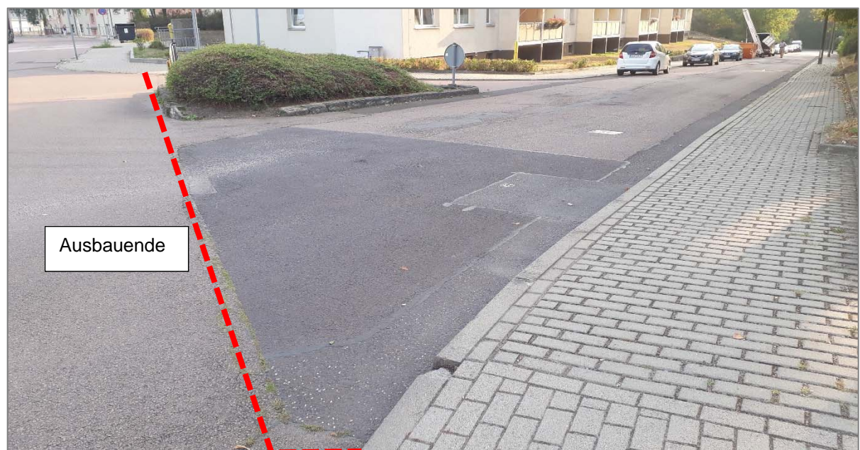
Einmündungsbereich Ilberstedter Straße
