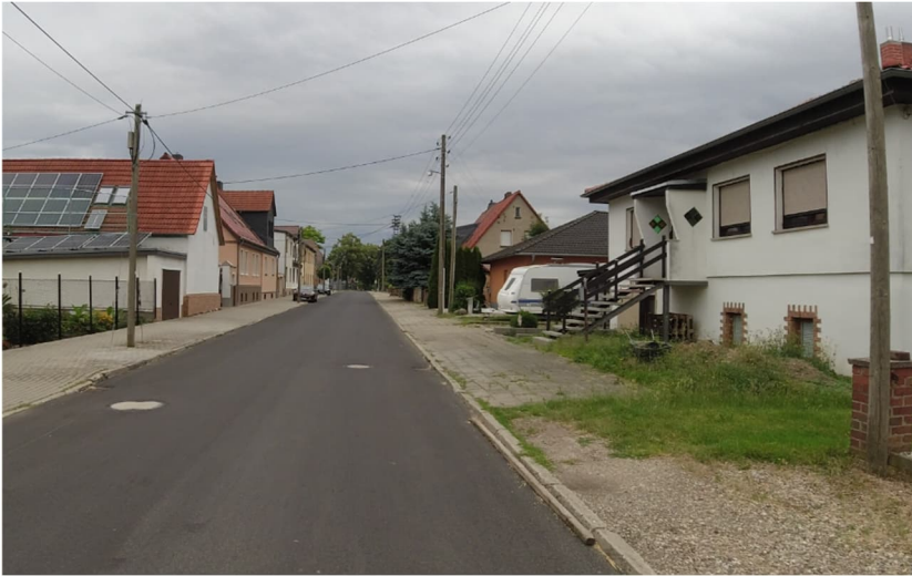
Baalberger Straße 2. BA Gehweg Ostseite – unbefestigte Flächen, „Hilfe“ für Zufahrt über Hochbord
