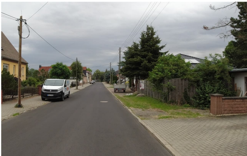
Baalberger Straße 2. BA Gehweg Ostseite – neuere Einfahrten neben unbefestigten Bereichen
