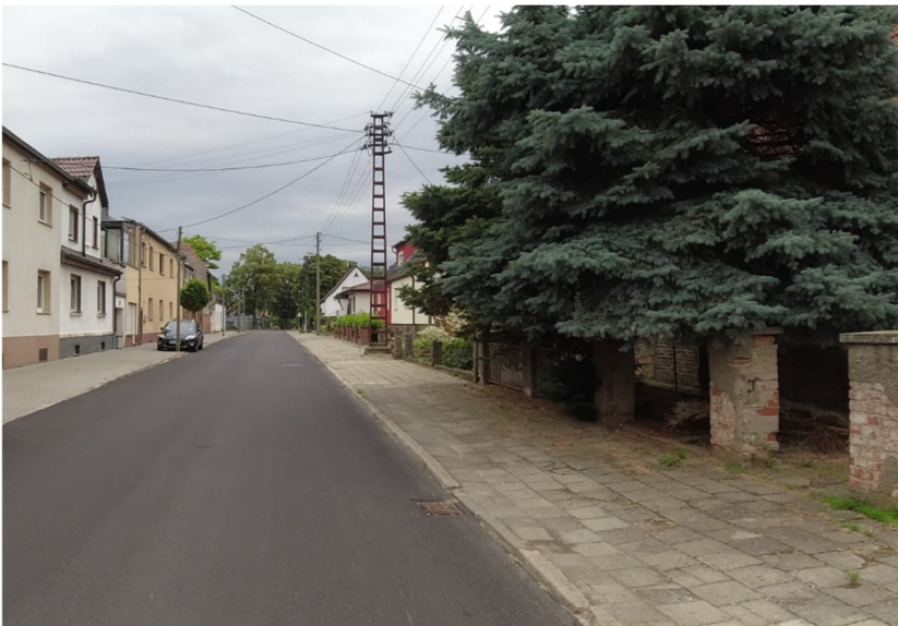
Baalberger Straße 2. BA Gehweg Ostseite – Betonplatten mit erheblichen Setzungen, Oberflächenwasser läuft nicht ab
